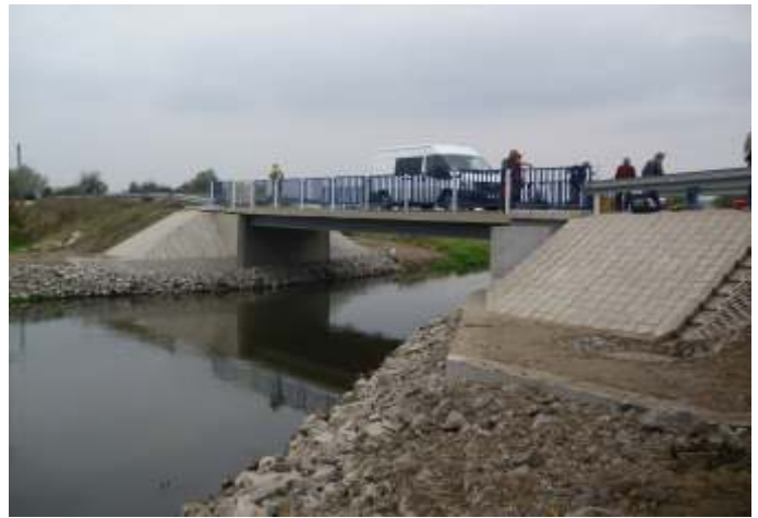
Remont mostu na rzece Sannie w Kosinie
