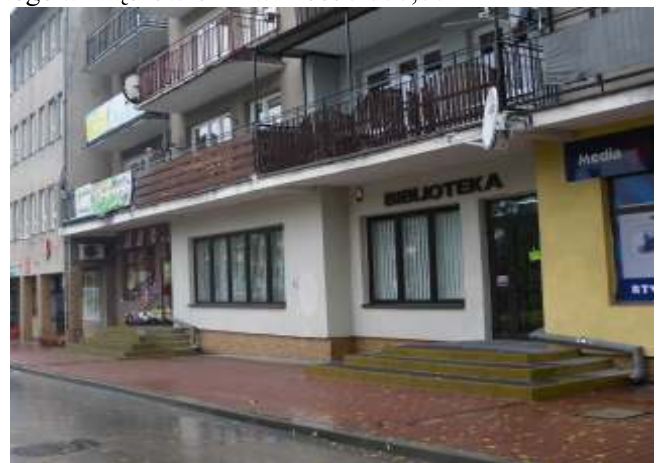
Wyremontowane schody w Annopolu przy ul. Rynek 1
