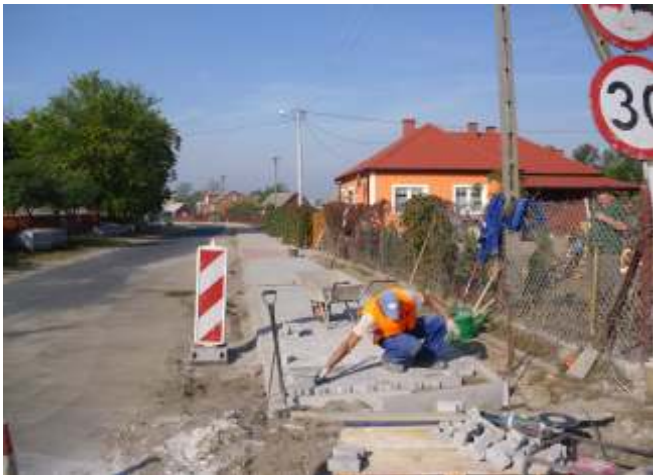
Remont chodnika przy drodze wojewódzkiej w Kosinie
