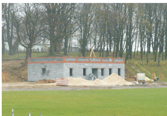
Modernizacja stadionu sportowego w Annopolu - budowa budynku socjalnego
