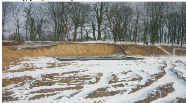
Rozpoczęta modernizacja stadionu sportowego w Anopolu
