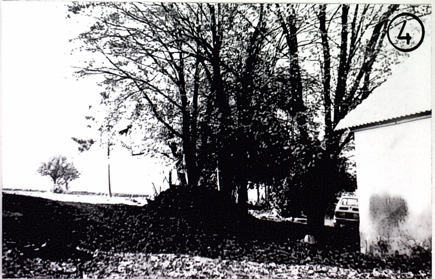
3/ D . gazon, widok od dworu. LX 1978r. PKZ. Lublin 4/ Szpaler grabowy przy dworku. LX 1978r. PKZ. Lublin
