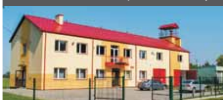
Świetlica w Białowoli po modernizacji
