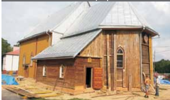
Remont drewnianego kościoła p.w. św. Jana Chrzciciela i św. Andrzeja Ap. w Blińowie
