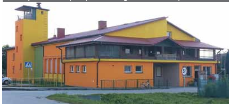
Wyremontowany budynek Gminnego Centrum Kultury w Polichnie
