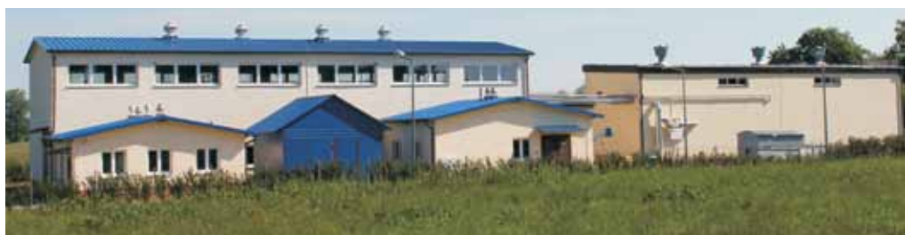
Rozbudowa oczyszczalni ścieków w Trawnikach
