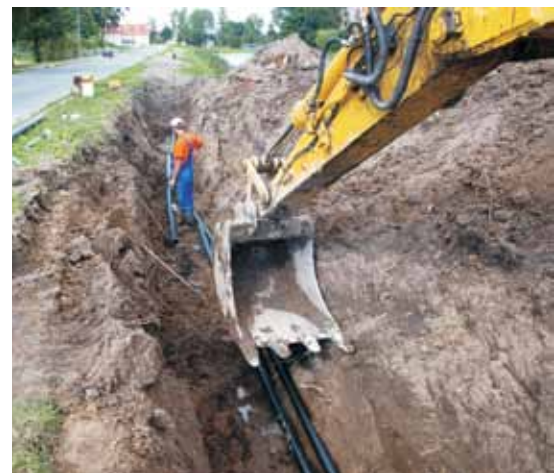
Rozbudowa sieci kanalizacyjnej wraz z częściową przebudową sieci wodociągowej na terenie aglomeracji Piotrowice, współfinansowana ze środków unijnych – RPO WL na lata 2007-2013. Wartość inwestycji: 3 870 193,10 zł, kwota dofinansowania z EFRR: 1 949 341,74 zł.
