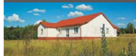
Odremontowana świetlica w Wierzchowinach
