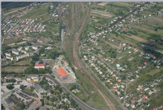
Dęblin stanowi ważny węzeł drogowy i kolejowy
