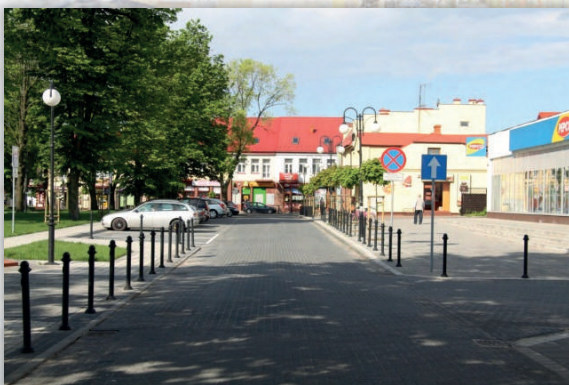
Rewitalizacja centrum miasta Dęblin
