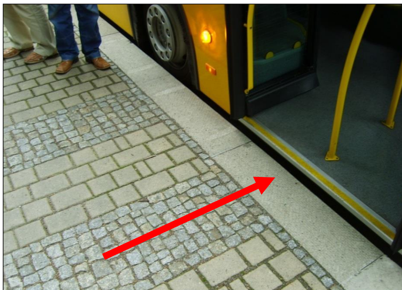
Rys. VII.3.3. Strefa wejściowa do pojazdu – inny rodzaj nawierzchni naprzeciwko pierwszych drzwi autobusu
