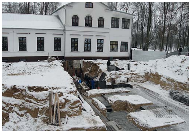
Budowa internatu w Kęble
