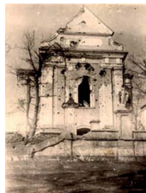
Obraz zniszczeń kościoła
