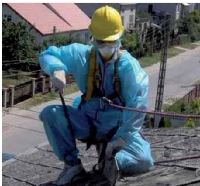
Usuwanie eternitu przez firmy specjalistyczne
