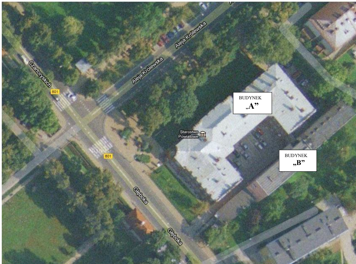
Widok ogólny obiektu.
