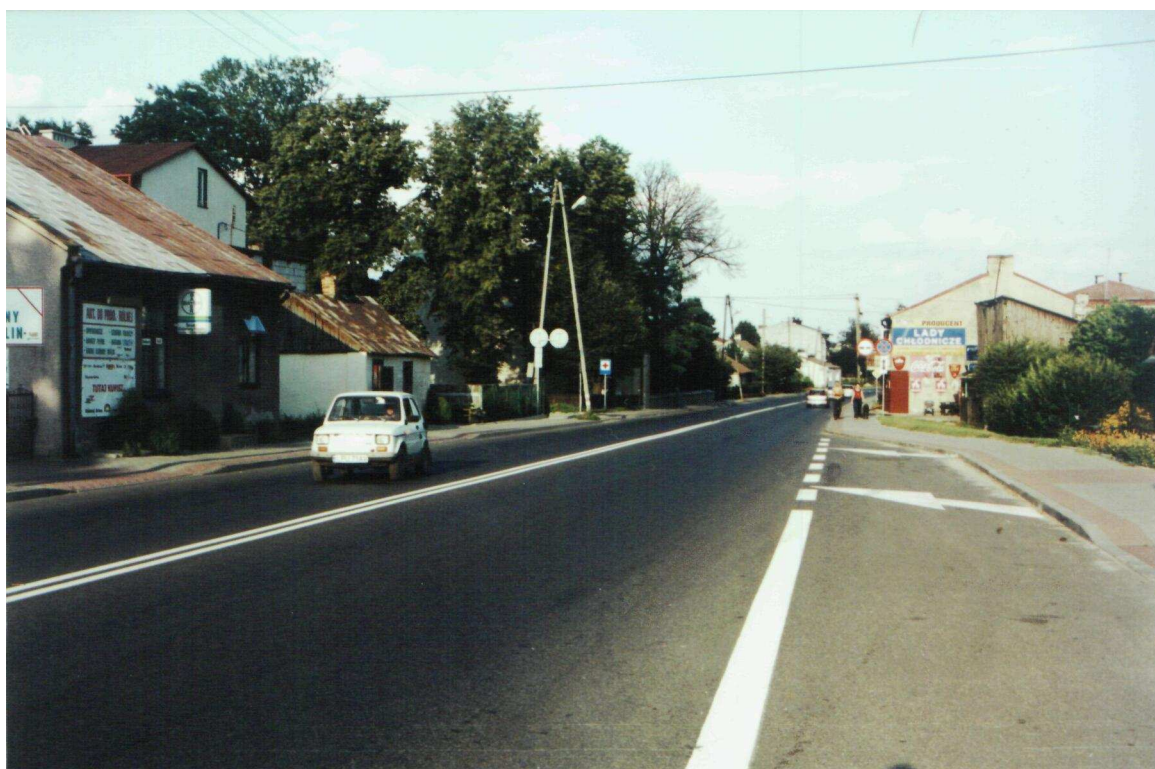
Fot.31. Szosa nr 17 Warszawa-Lublin w Markuszowie
