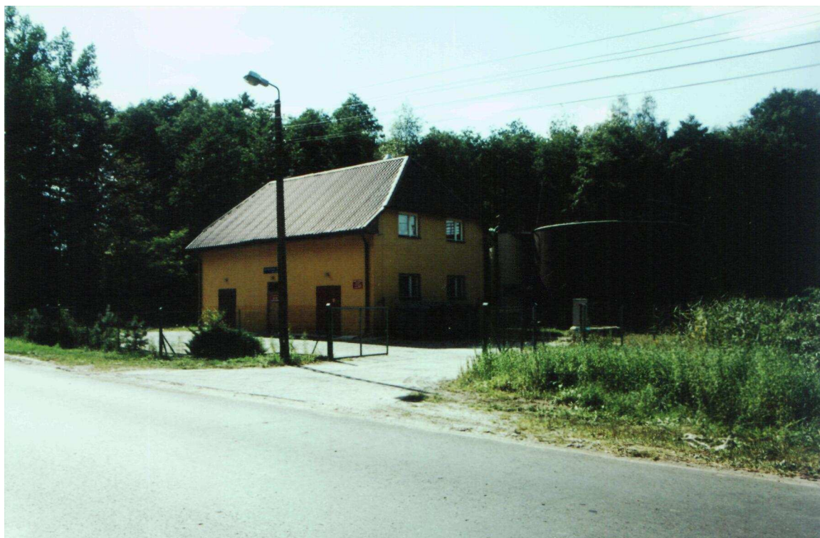
Fot.38. Oczyszczalnia ścieków w Żyrzynie
