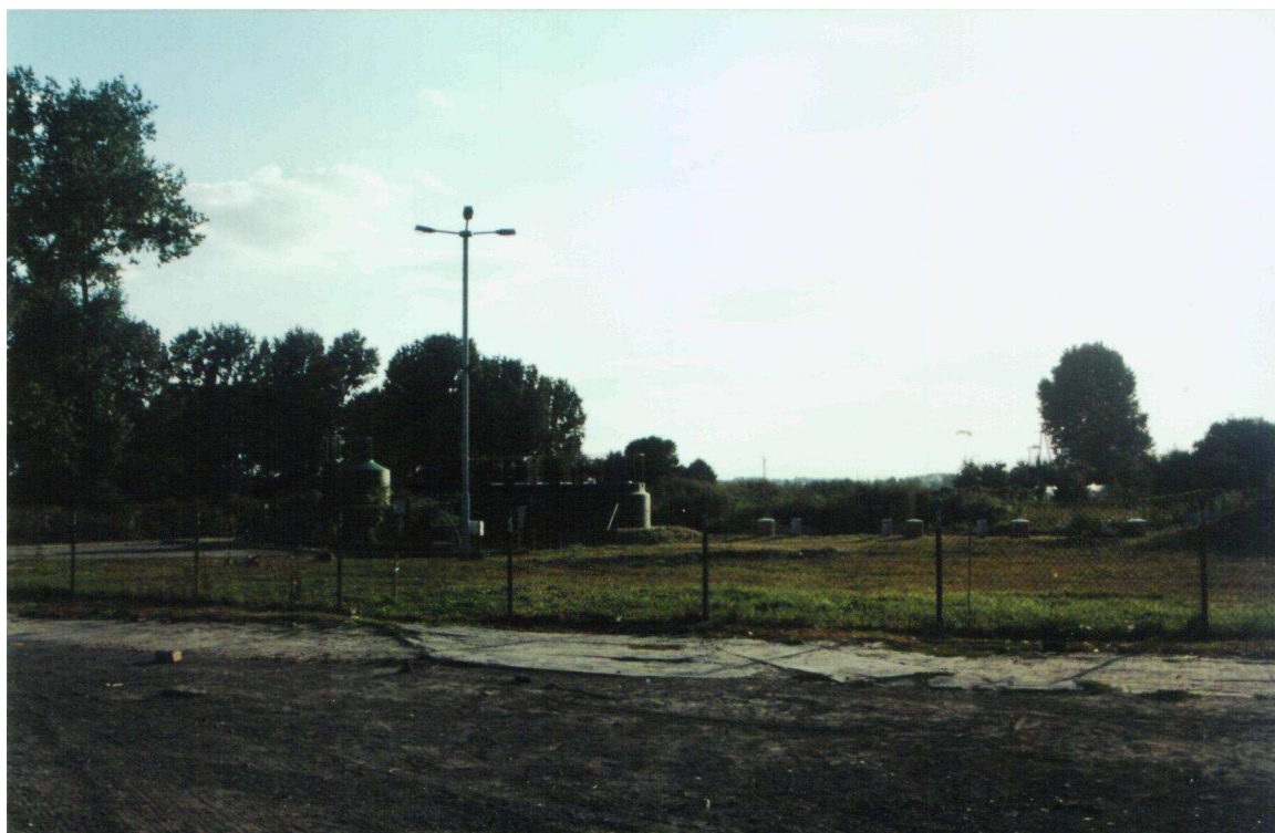
Fot.32. Oczyszczalnia ścieków w Markuszowie
