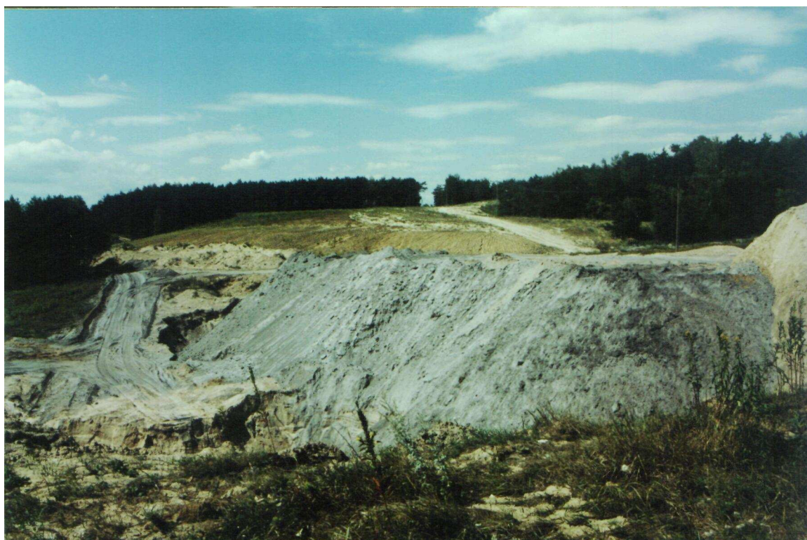
Fot.19. Rekultywacja wyrobiska w miejscowości Trzcianki z zastosowaniem pyłów dymnicowych z Z.A. Puławy
