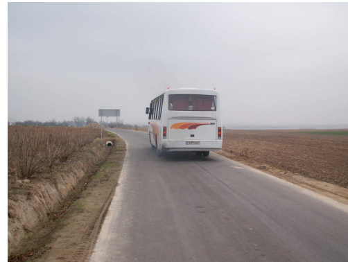
Foto: Nowa droga w Woli Trzydnickiej
