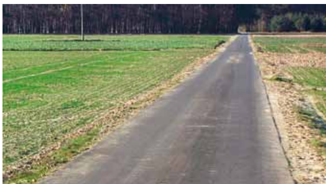
Droga: Kępa Borzechowska i Kępa Kolonia
