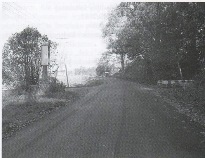
Mieszkańcy Piotrowic Wielkich doczekali się nowej asfaltowej drogi
