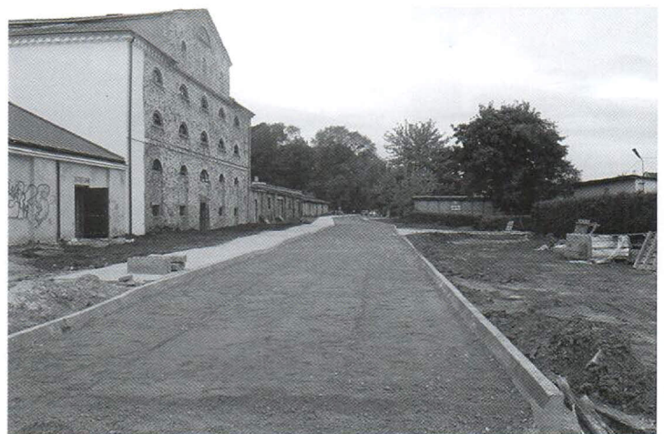
Budowa drogi młyńskiej w Garbowie
