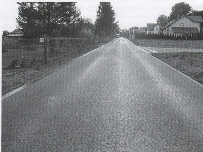
Nowa nawierzchnia asfaltowa w Zagrodach
