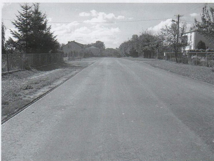
Nowa nawierzchnia drogi powiatowej Karolin-Borków-Janów, wybudowana z udziałem gminy - pomoc finansowa wyniosła 422 tys zł
