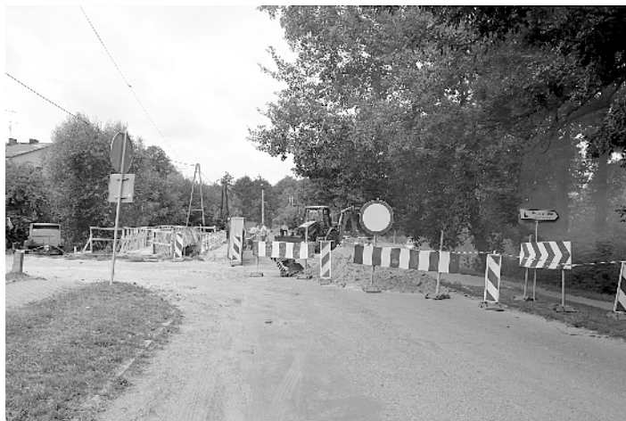
Garbów - remont drogi powiatowej i mostu na rzece Kurówce
