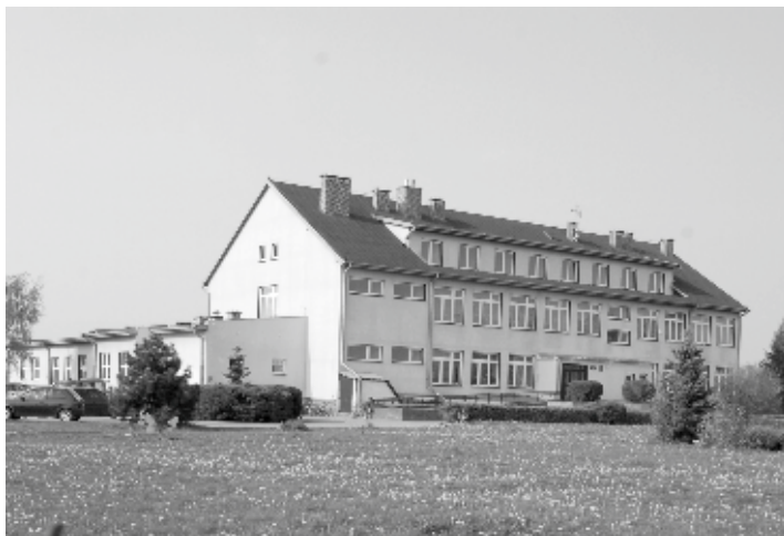
Budynek Szkoły Podstawowej w Leścach
