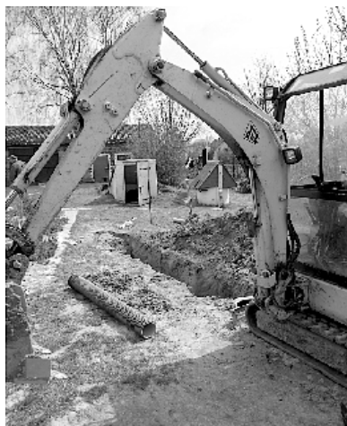
Garbów budowa kanalizacji etap II
