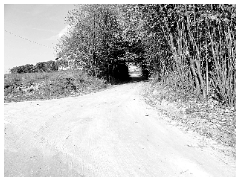
Gutanów – wąwóz, podbudowa betonowa
