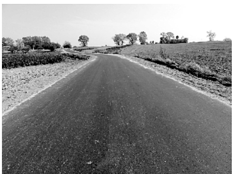
Garbów – Kolonia Słoneczna – droga asfaltowa
