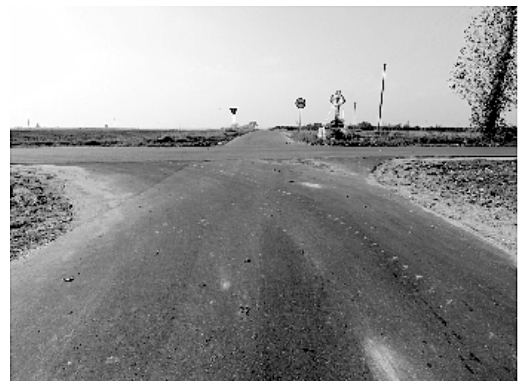
Wola Przybysławska – skrzyżowanie drogi gminnej z drogą powiatową
