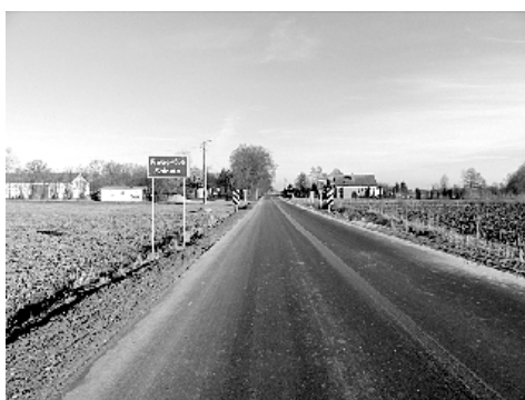
Leśce droga powiatowa
