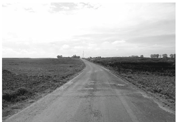
Bogucin – nawierzchnia asfaltowa
