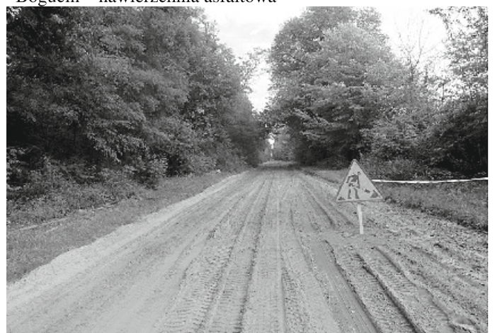
Budowa drogi powiatowej Wola Przybyśławska-Meszno
