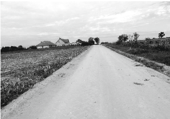
Przybyśławice - podbudowa betonowa
