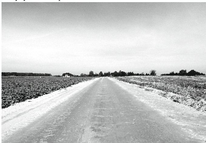
Gutanów – podbudowa betonowa na drodze powiatowej
