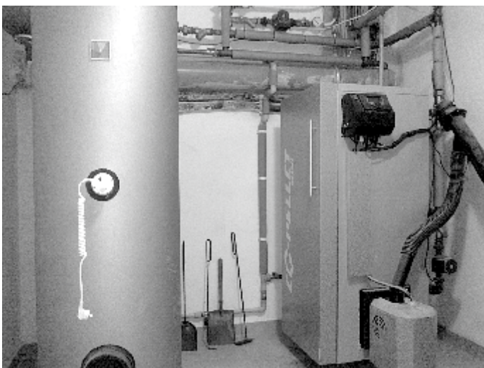
Kotły centralnego ogrzewania (fot. arch. gminy)
