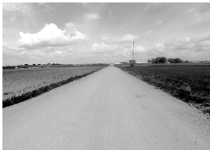
Podbudowa betonowa w Bogucinie
