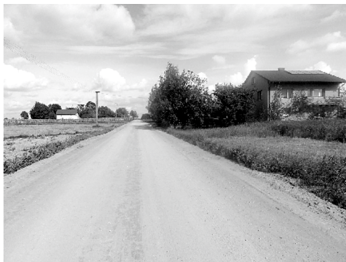
Podbudowa betonowa na ul. Wspólnej w Garbowie (fot. K. Firlej)
