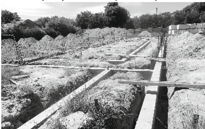
Budowa sali gimnastycznej w Bogucinie
