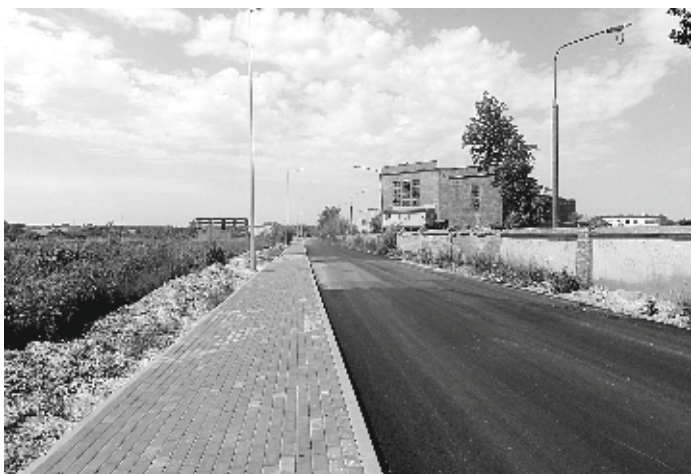
Budowa drogi gminnej w Zagrodach i Przybysławicach
