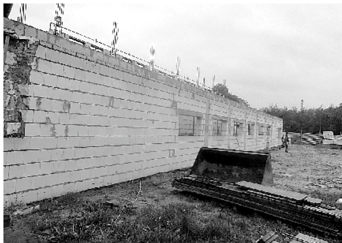
Trwają prace przy budowie sali gimnastycznej przy szkole podstawowej w Bogucinie – można już zaobserwować znaczne zaawansowanie prac.
