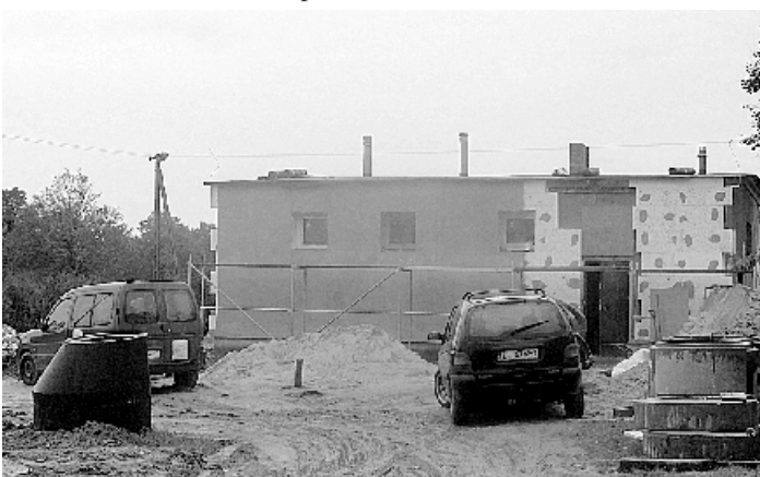
Widoczny jest postęp robót przy przebudowie stacji wodociągowej w Borkowie. Termin zakończenia tej inwestycji jest przewidziany na koniec listopada bieżącego roku.
