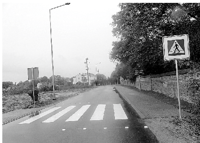
Została zakończona budowa drogi gminnej w Zagrodach i Przybysławicach realizowanej w ramach
