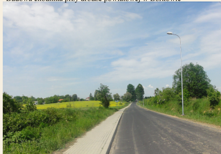
Oświetlenie drogi powiatowej Garbów – Wola Przybysławska
