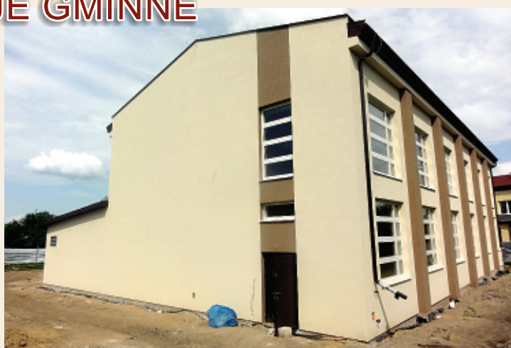
Budowa sali gimnastycznej w Bogucinie
