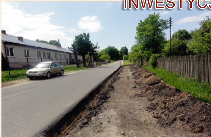
Budowa chodnika przy drodze powiatowej w Borkowie
