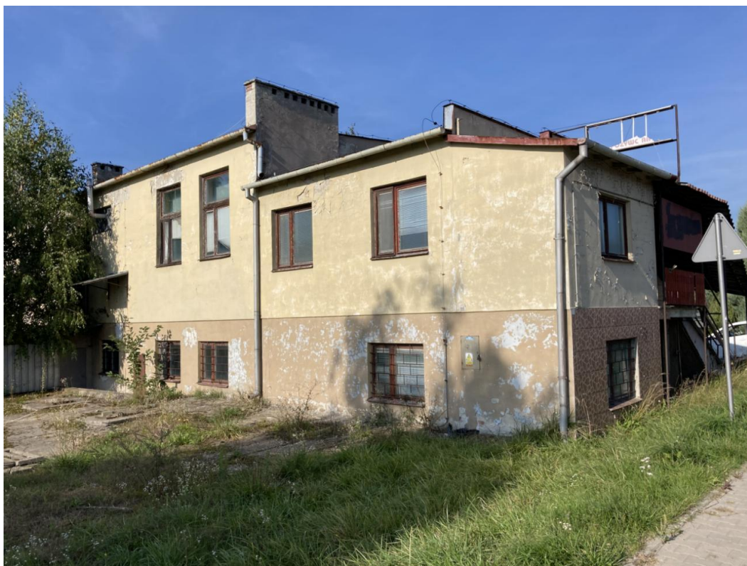
ZDJ. 2 Budynek przeznaczony do rozbiórki.
