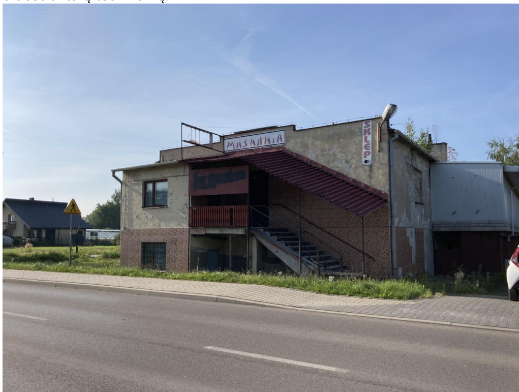
ZDJ. 1 Budynek przeznaczony do rozbiórki.
