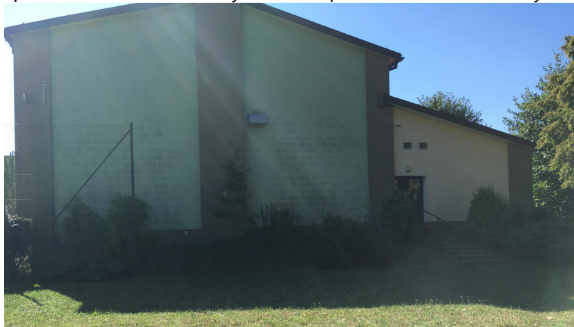
Zdj. 1 Część elewacji południowej - miejsce projektowanej rozbudowy.
