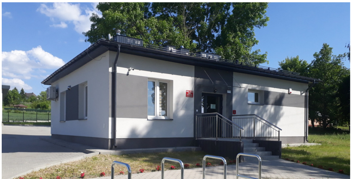
Zdjęcie 3. Remont budynku po byłym posterunku policji
