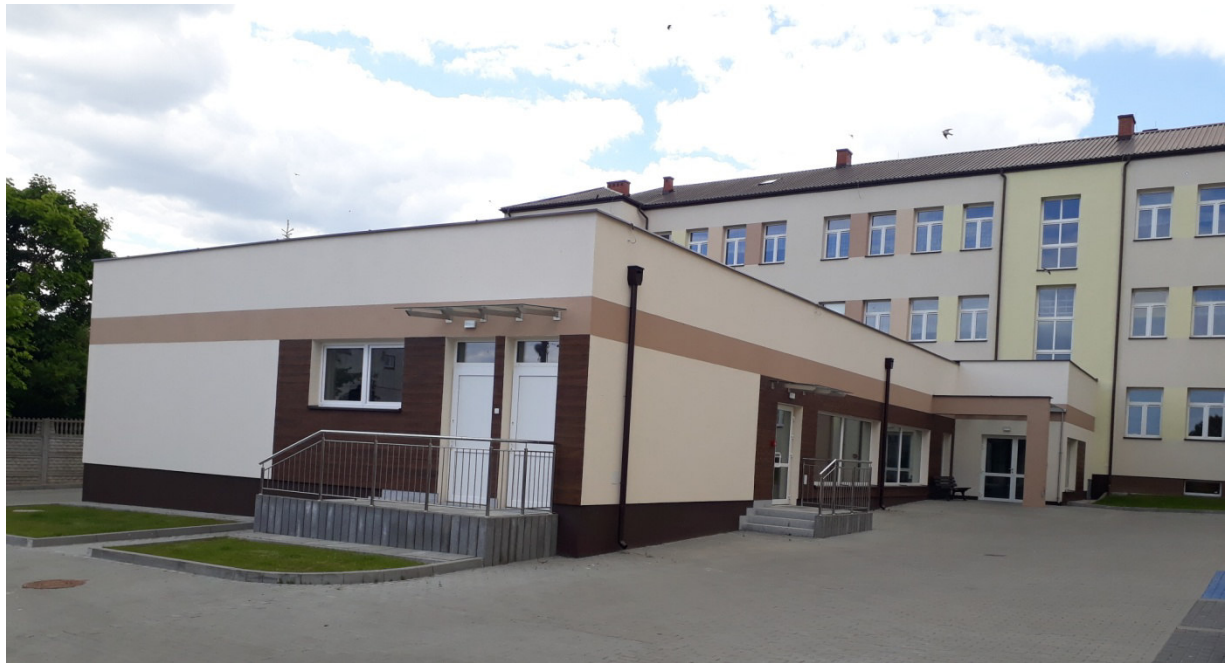
Zdjęcie 2. Budowa stołówki przy Zespole Szkół w Wysokiem
