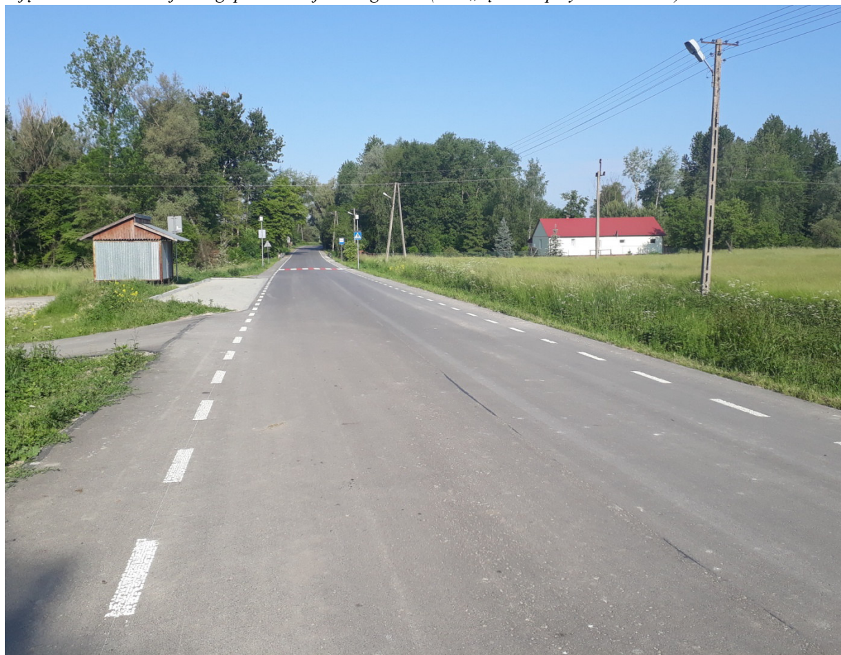
Zdjęcie 5. Modernizacja drogi powiatowej w Draganach (tzw. „łącznik” przy remizie OSP)
