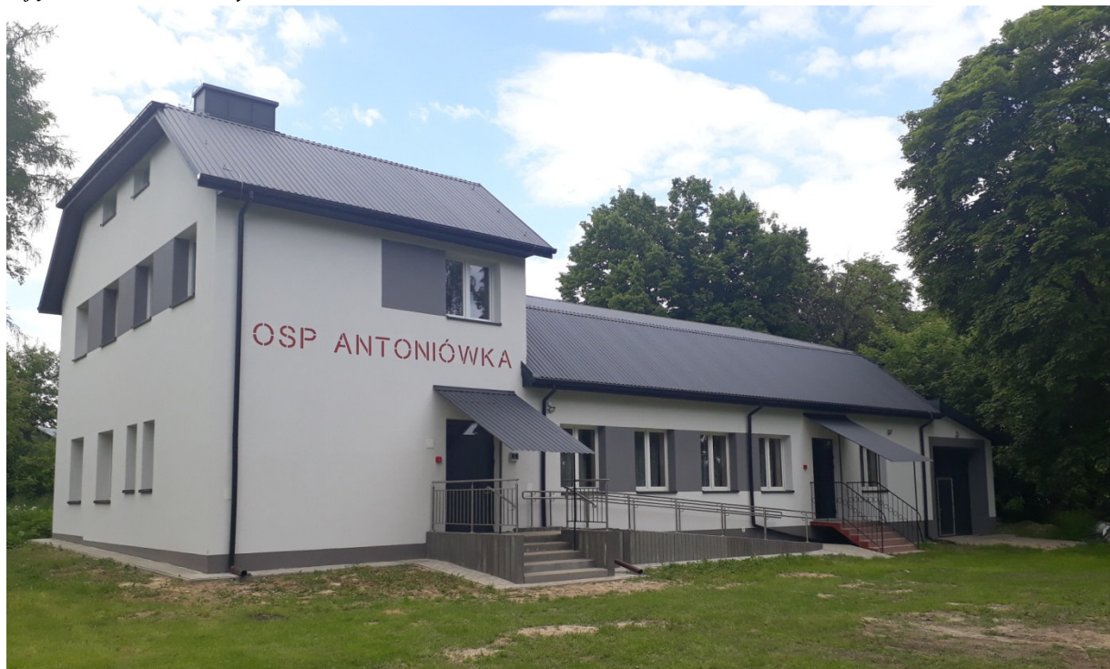
Zdjęcie 4. Remont remizy OSP w Antoniówce
