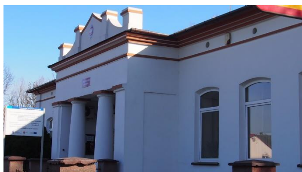
Fot. 3. Budynki Urzędu Gminy w Jabłonie
