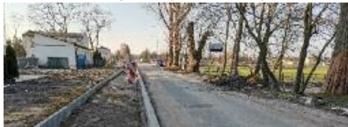
Rozpoczęcie prac na przebudowie drogi tzw. Zapłocie
