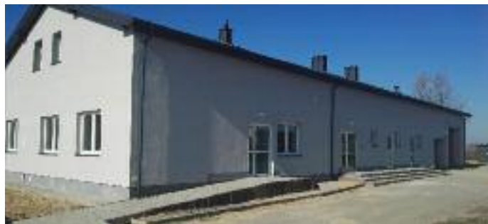
Remiza OSP w Jabłonne po modernizacji w 2019 roku
