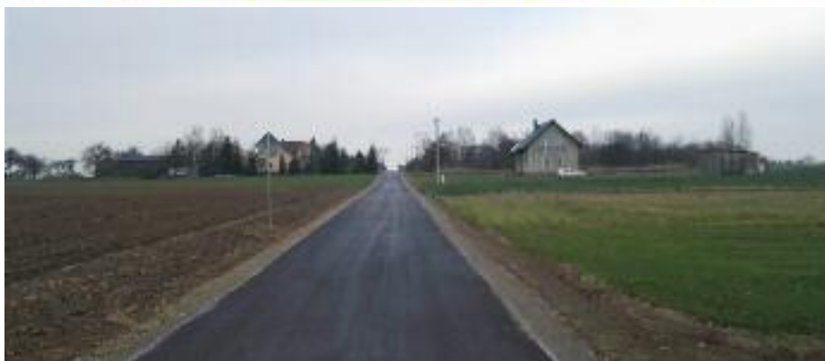
Przebudowana tzw. droga Czereśniowa w Jabłonie Drugiej
