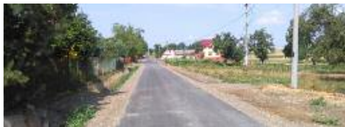
Przebudowana droga w miejscowości Wolnica
