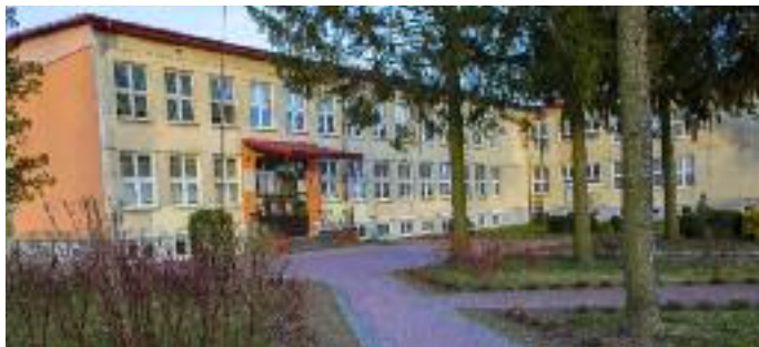
Budynek ZS w Piotrkowie przed termomodernizacją w 2018 roku
