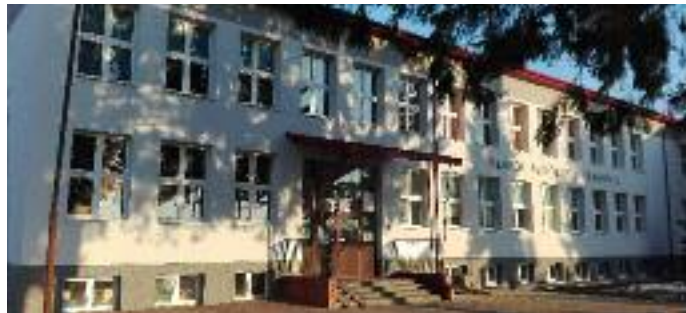
Budynek ZS w Piotrkowie po termomodernizacji w 2019 roku
