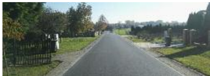
Przebudowana tzw. droga Słoneczna w Jabłonie-Majątek
