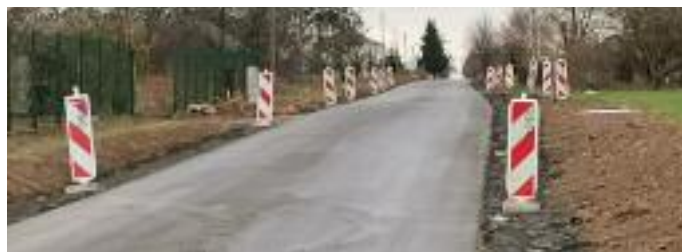
Przebudowana droga w miejscowości Skrzynice-Kolonia
