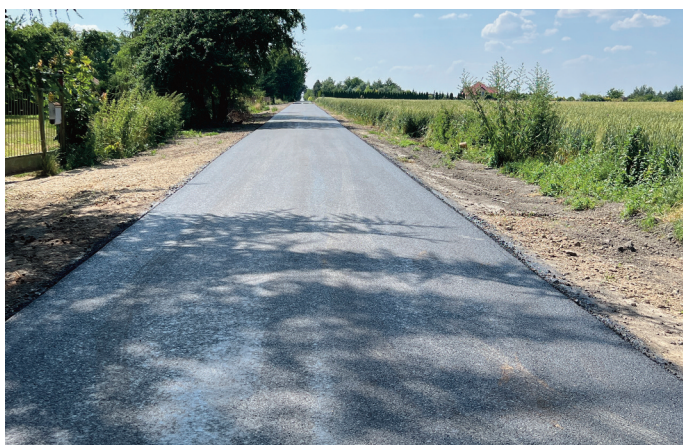
Budowa drogi tzw. Wesolej w Jabłonie Pierwszej
