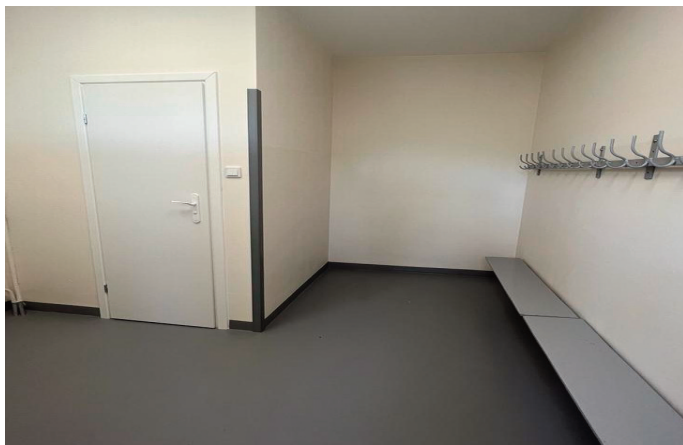
Remont szatni sportowej w Zespole Szkół w Jabłonie
