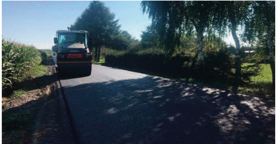
Budowa Trzynastki w Skrzynicach Pierwszych
