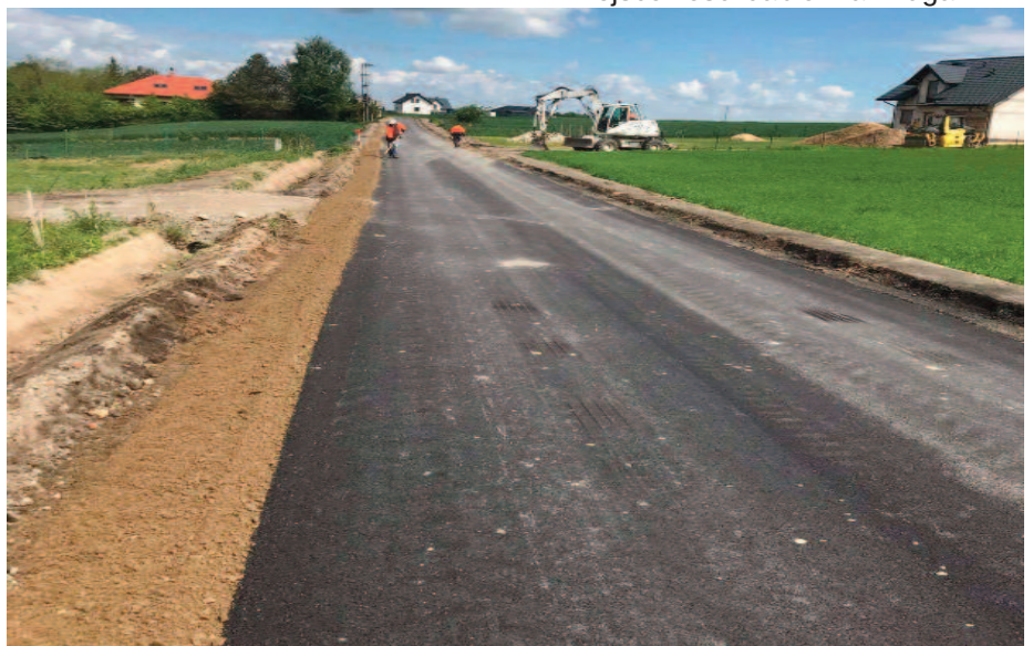
Budowa drogi w Czerniejowie-Kolonii
