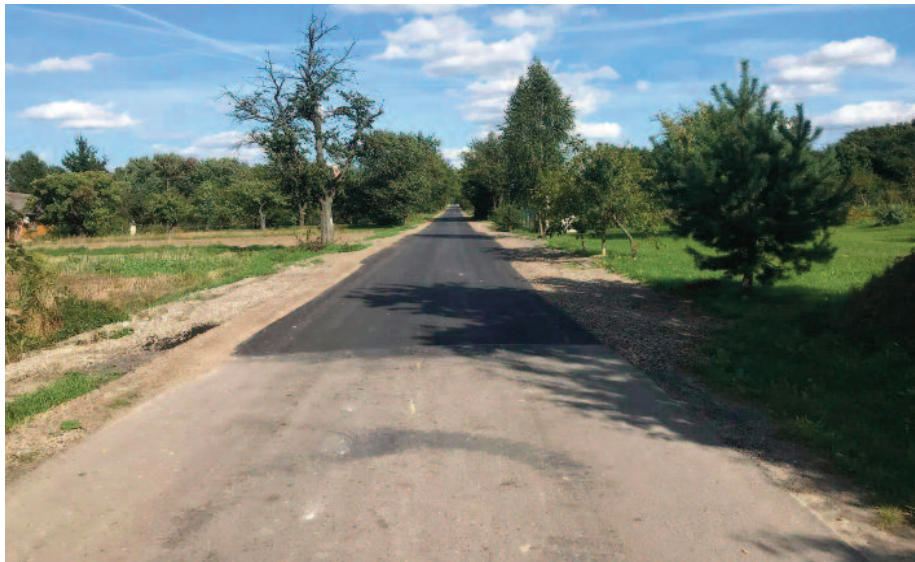
Budowa Piątki w Skrzynicach Drugich
