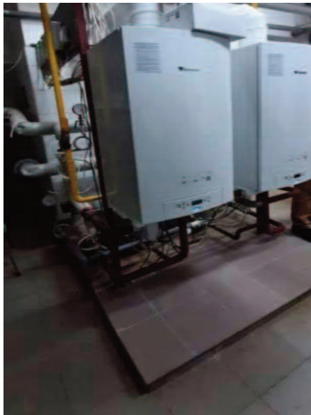
Modernizacja kotłowni w Zespole Szkół w Jabłonie
