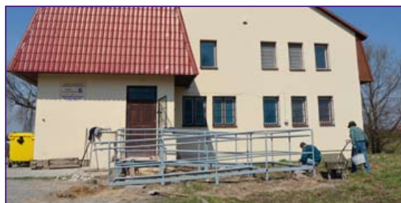
Przy budynku został już zamontowany podjazd dla osób niepełnosprawnych oraz dla wózków
