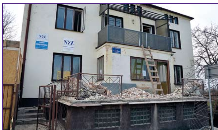
Garażowa część obecnego budynku Ośrodka Zdrowia zostanie zdemontowana
