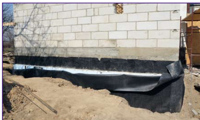
Prace przy remoncie kapitalnym Ośrodka Zdrowia już trwają
