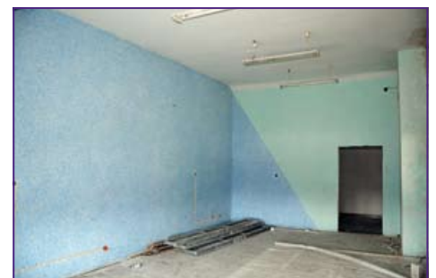
Remontu doczeka się także wnętrze budynku
