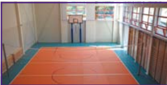
Budowa sali sportowej przy Zespole Placówek Oświatowych w Dysie wartość brutto: 1 993 532,86 zł
