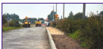
Budowa chodnika przy drodze powiatowej nr 1564L w m. Leonów
