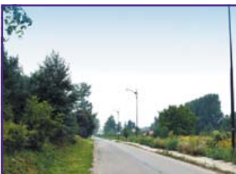
Budowa oświetlenia przy drodze powiatowej nr 2217L Ciecierzyn - Dys i przy drogach gminnych nr 106093L i nr 106055L w m. Dys
