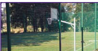
Budowa ogólnodostępnego boiska sportowego w miejscowości Ciecierzyn w ramach działania 413 "Wdrażanie lokalnych strategii rozwoju" PROW 2007-2013 wartość brutto 319 010,00 zł
