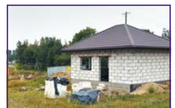
Budowa stałego targowiska gminnego Mój Rynek w miejscowości Krasienin Kolonia gmina Niemce w ramach działania 321 „Podstawowe usługi dla gospodarki i ludności wiejskiej” w ramach Programu Rozwoju Obszarów Wiejskich na lata 2007-2013
