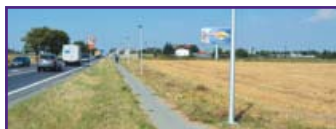
Budowa oświetlenia chodnika przy drodze krajowej nr 19 oraz skrzyżowania dróg: krajowej nr 19, powiatowej nr 2218L oraz gminnej nr 111429L w miejscowości Niemce i Wola Niemiecka, gm. Niemce.
