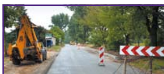
Budowa chodnika przy drodze powiatowej nr 1564 L w m. Dziuchów na dł. około 1200 m
