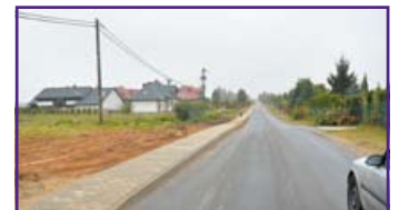
Przebudowa chodnika przy drodze gminnej 106061 L w m. Jakubowice Konińskie
