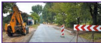
Budowa chodnika w m. Majdan Krasieniński w ciągu drogi wojewódzkiej Nr 809
