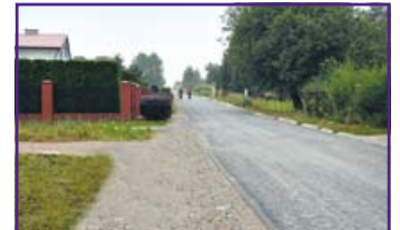
Modernizacja-przebudowa drogi gminnej nr 106041L w m. Jakubowice Konińskie Kolonia
