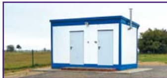
Budowa stacji wodociągowej w Nasutowie na bazie istniejącej studni wierconej wraz z włączeniem do istniejącej sieci wodociągowej wartość brutto: 236 984,10 zł
