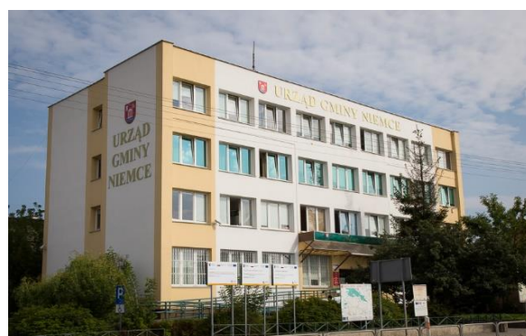
Elewacja budynku Urzędu Gminy Niemce
