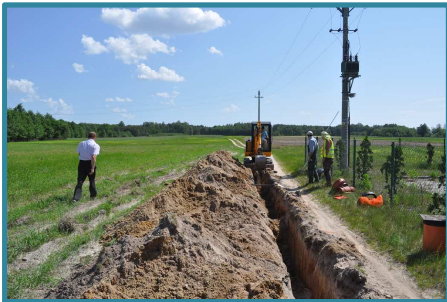
Budowa kanalizacji w m. Jedlinki, arch. UG
