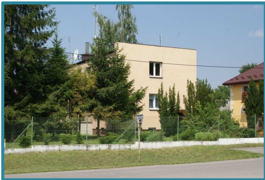
Zmodernizowany ośrodek zdrowia w m. Potok Górny
