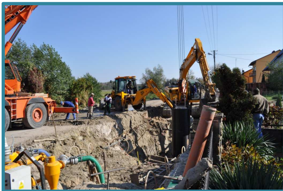
Budowa kanalizacji w m. Jasiennik Stary, arch. UG
