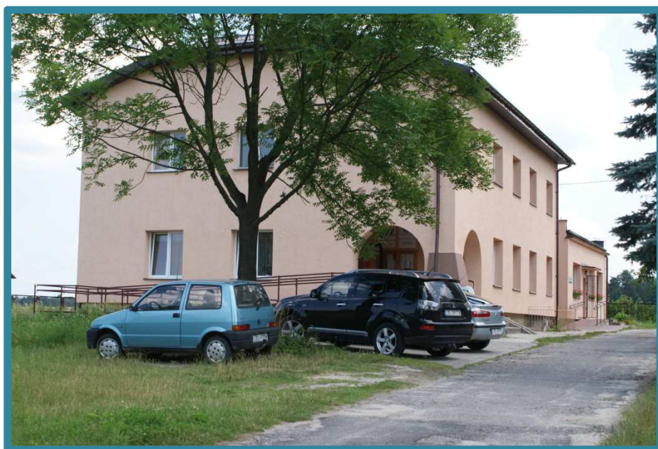
Zmodernizowany ośrodek zdrowia w m. Lipiny Górne-Lewki
