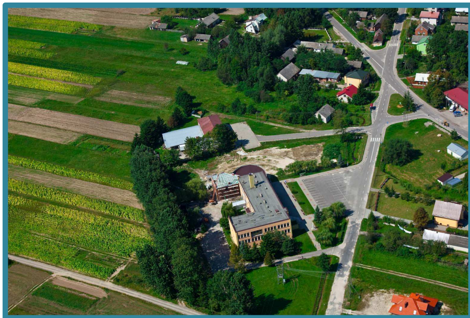
Teren wokół Urzędu Gminy, etap budowy, arch. UG
