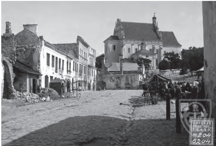
Fot. 51. Zrujnowana południowa zabudowa kazimierskiego rynku
