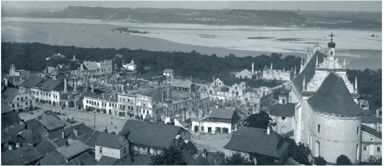
Fot. 50. Zniszczona południowa zabudowa pierzei kazimierskiego rynku
