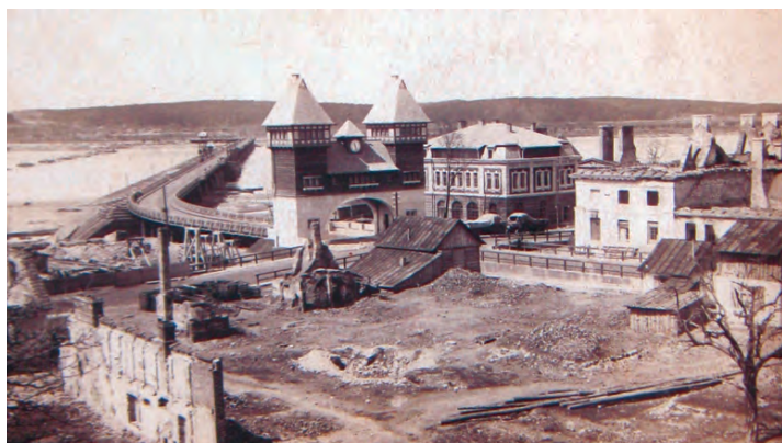
Fot. 75. Widok na zniszczoną zabudowę miejską w Puławach i odbudowany magistrat, ok. 1918 r.
