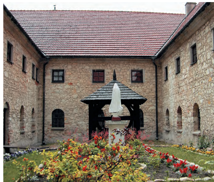
Fot. 58. Sale lekcyjne, kuchnia, stołówka i internat dla przyszłej Szkoły Rzemiosł Budowlanych w Kazimierzu, ulokowano w 1920 r. w opustoszałym Klasztorze OO. Reformatów
