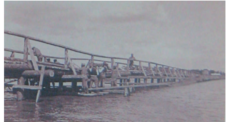
Fot. 64. Żołnierze austriaccy przy budowie tymczasowego mostu w Nowej Aleksandrii (Puławach), 1915 r.
