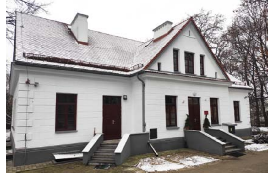
BUDYNEK MŁODZIEŻOWEGO DOMU KULTURY W PUŁAWACH
