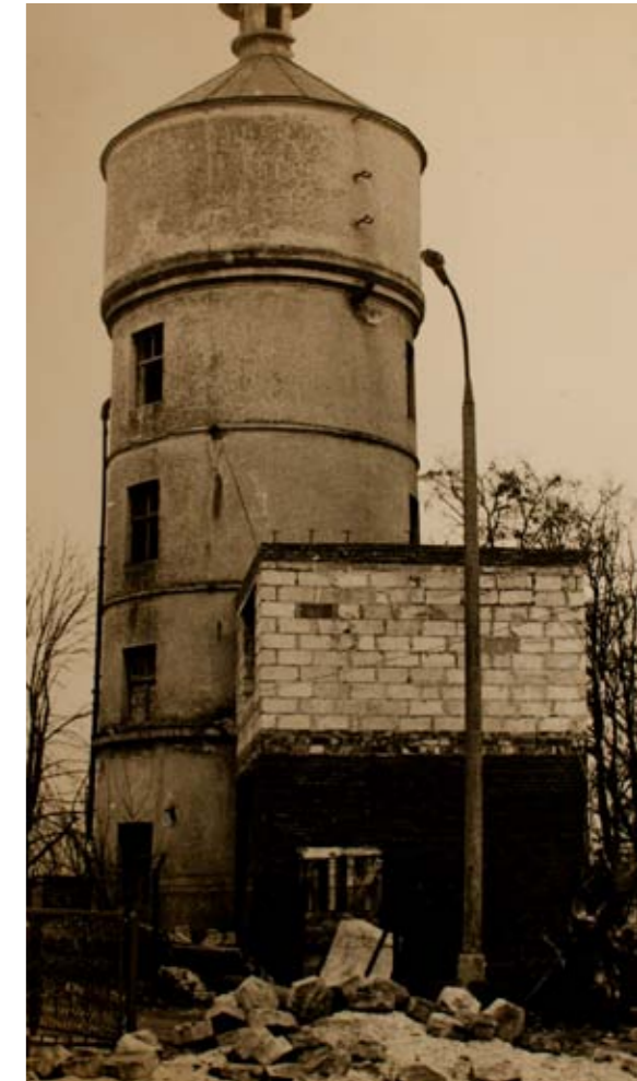
PRACE ADAPTACYJNE, 1983 R.
