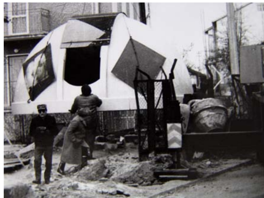
MONTAŻ KOPUŁY NA WIEŻY CIŚNIENI, 1988 R.
