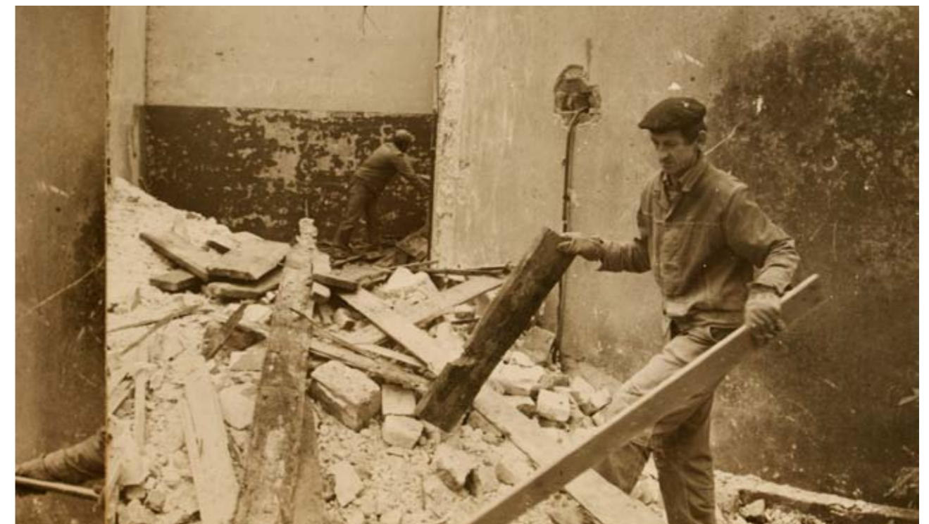
PRACOWNICY ZAKŁADU REMONTOWO-BUDOWLANEGO W TRAKCIE PRAC ADAPTACYJNYCH, 1981 R.
