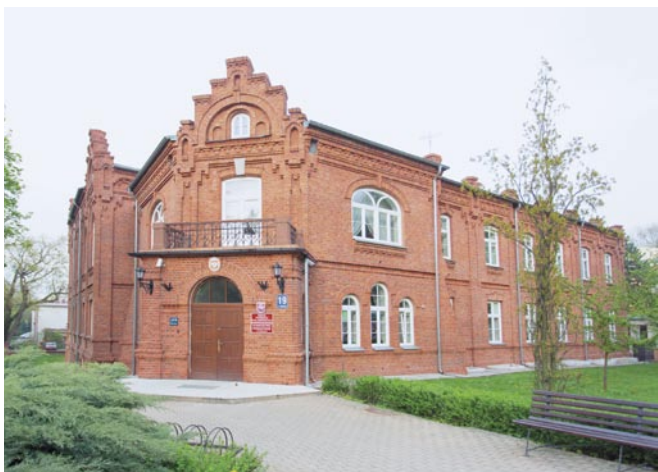
Fot. D. Malinowski, budynek Starostwa Powiatowego w Puławach
