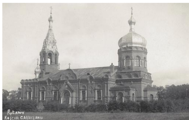
Cerkiew prawosławna dla wojsk rosyjskich, widok około 1910 r., została wzniesiona w stylu bizantyjsko-ruskim, z ceglаныmi gzymsami kordonowymi stanowiącymi horyzontalne podziały elewacji. Gzymsy wieńczące istnieją w formie kroksztynek.
