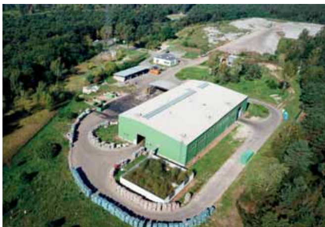
Zakład Utylizacji Odpadów Komunalnych w Puławach
