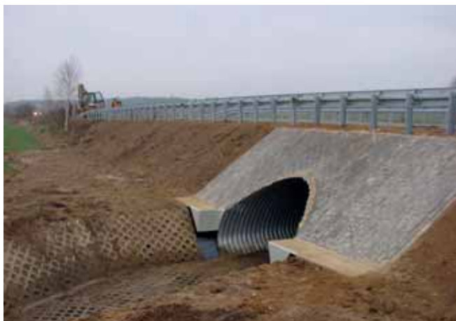
Remont mostu koło Żyrzyna
