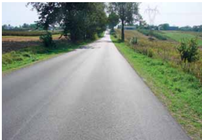
Remont drogi Końskowola – Celejów
