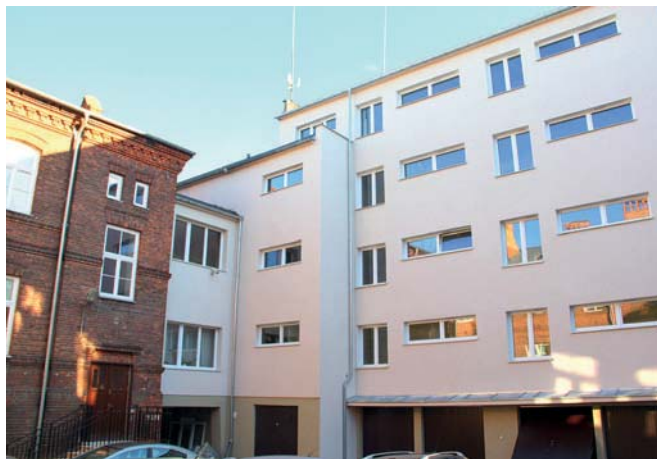
Budynek Starostwa po termomodernizacji
