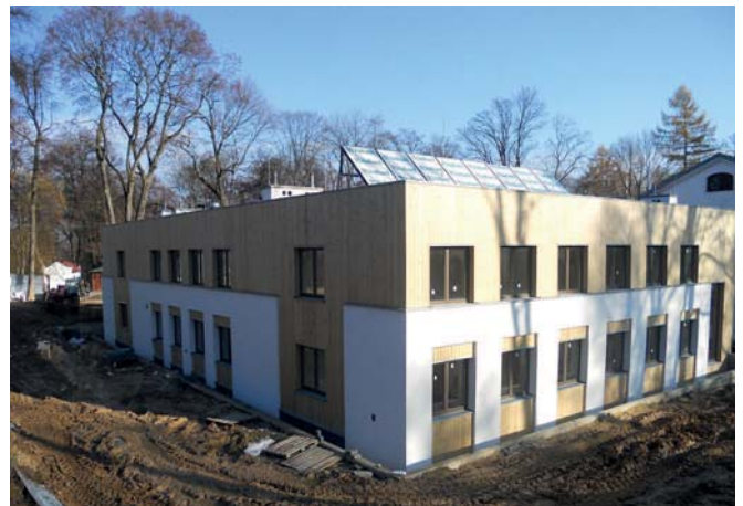
Budowa nowego internatu w Kęble
