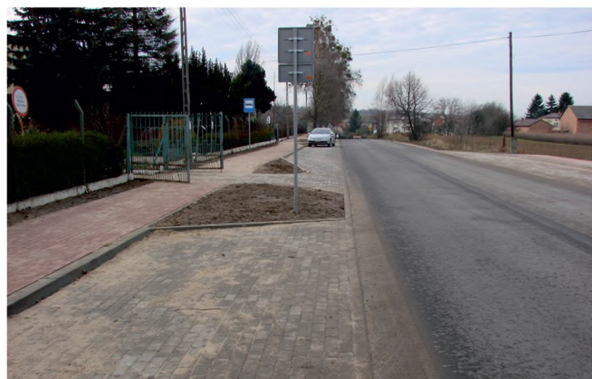
Chodnik w ciągu drogi powiatowej nr 1519L Żyrzyn – Kotliny – Dębiny
