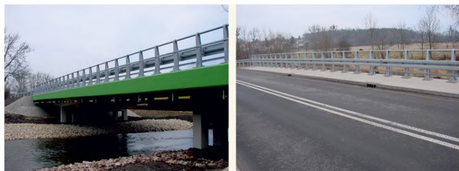
Most na rzece Kurówce w miejscowości Końskowola w km 0+374,00
