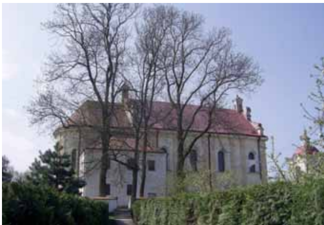
Kościół w Baranowie - widok elewacji bocznej
