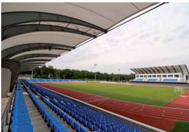
Stadion po modernizacji
