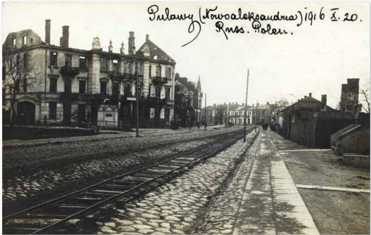
Zniszczona Restauracja i Hotel „Bristol”, Puławy 20 października 1916 roku
