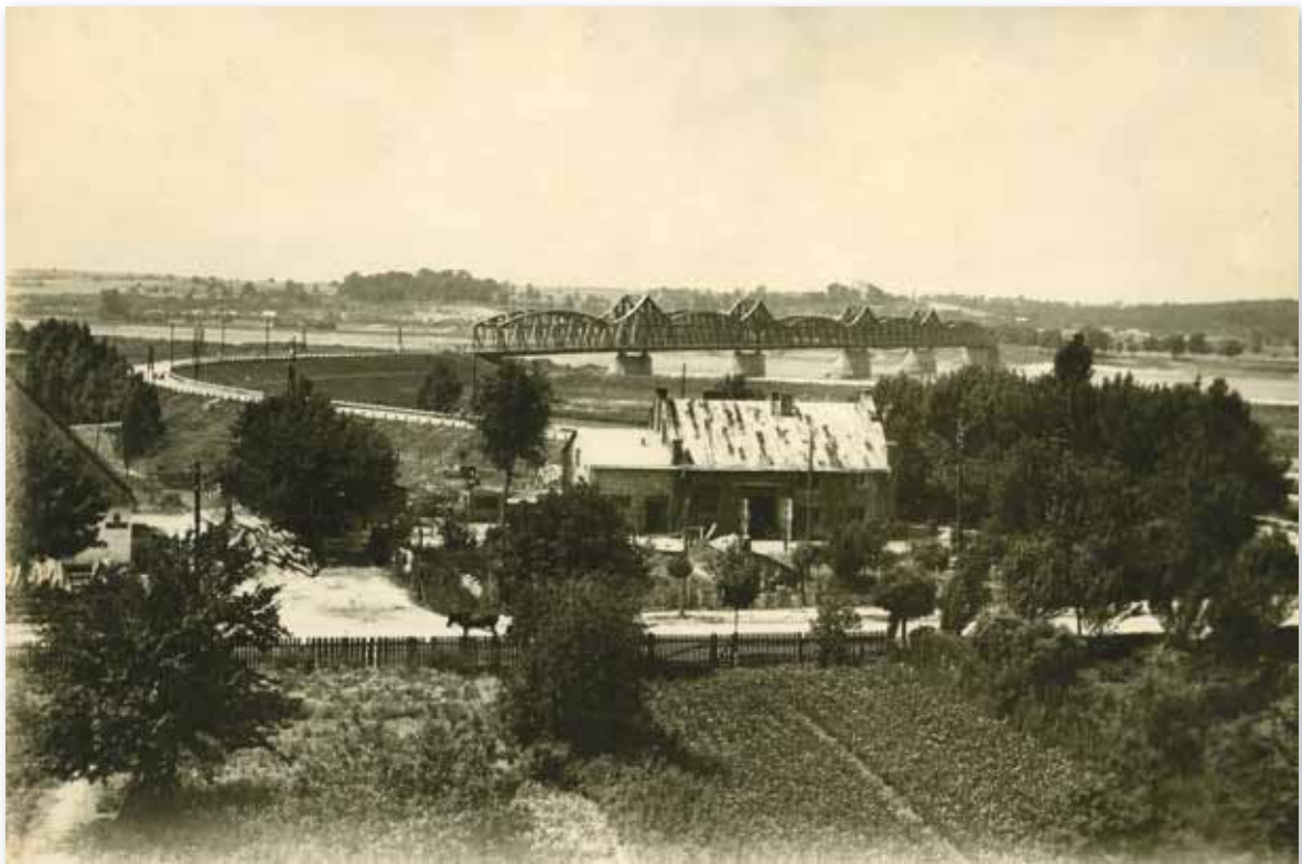
Widok na most i budynek elektrowni, Puławy koniec lat 40. lub początek lat 50. XX wieku
