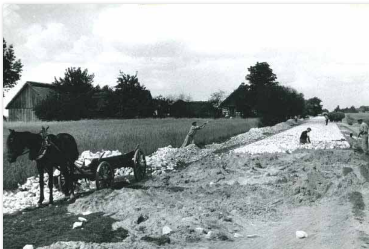
Budowa drogi w Rzeczycy (gmina Kazimierz Dolny), lata 60. lub 70. XX wieku
