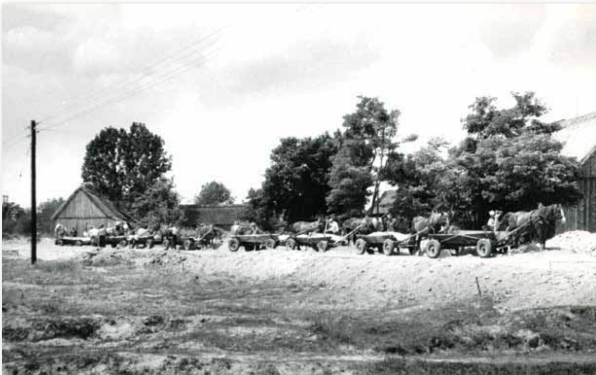
Budowa drogi Baranów – Skrudki (gmina Baranów) w czynie społecznym, najprawdopodobniej lata 70. XX wieku
