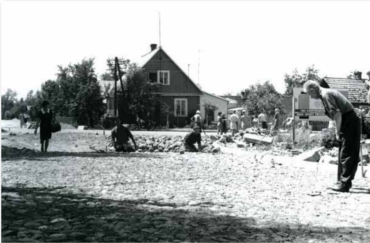
Budowa drogi w Gołębiewo (gmina Puławy), lata 60. XX wieku
