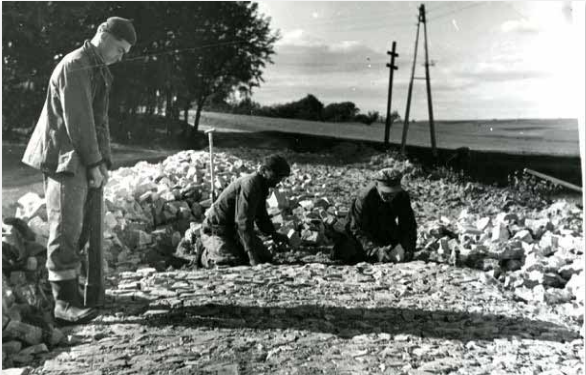
Budowa drogi w Buchałowicach (gmina Kurów), lata 60. lub 70. XX wieku
