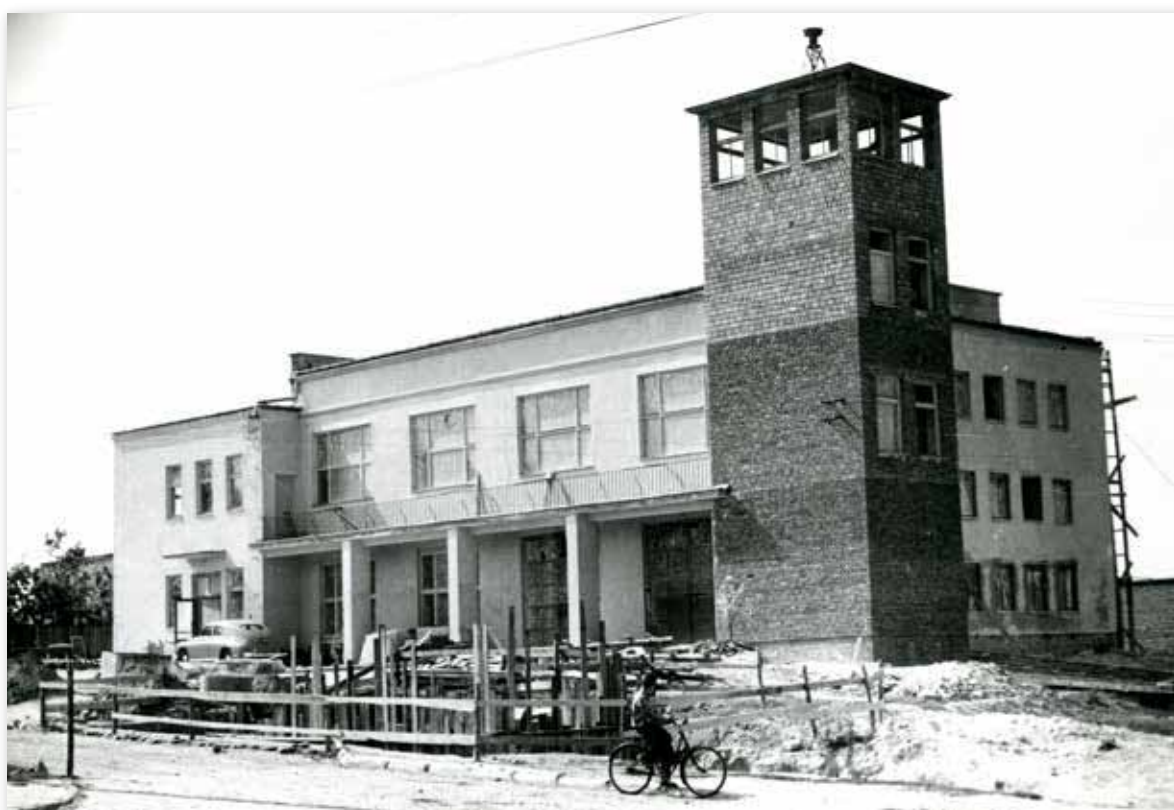
Budowa remizy Ochotniczej Straży Pożarnej w Kurowie, lata 60. XX wieku
