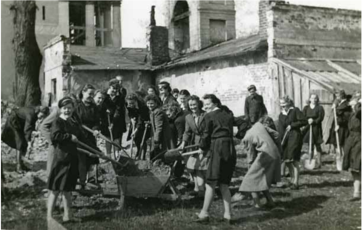
Odgruzowywanie budynku starej szkoły przy kościele parafalnym przez młodzież szkolną, Puławy kwiecień 1948 roku
