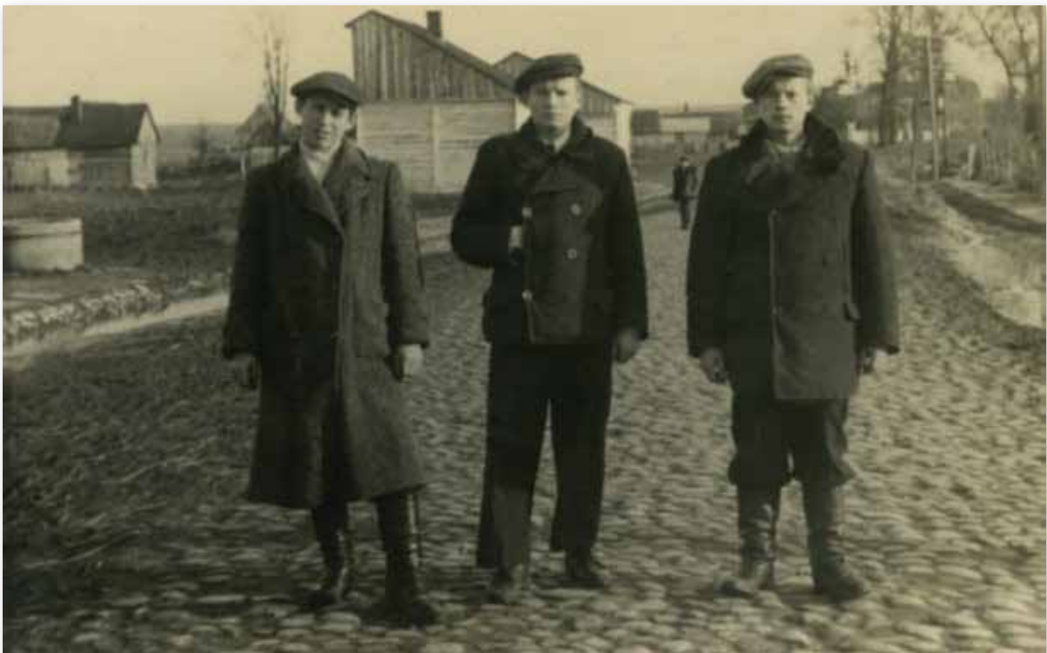
Mieszkańcy Markuszowa na tle zabudowy mieszkalnej, lata 40. XX wieku
