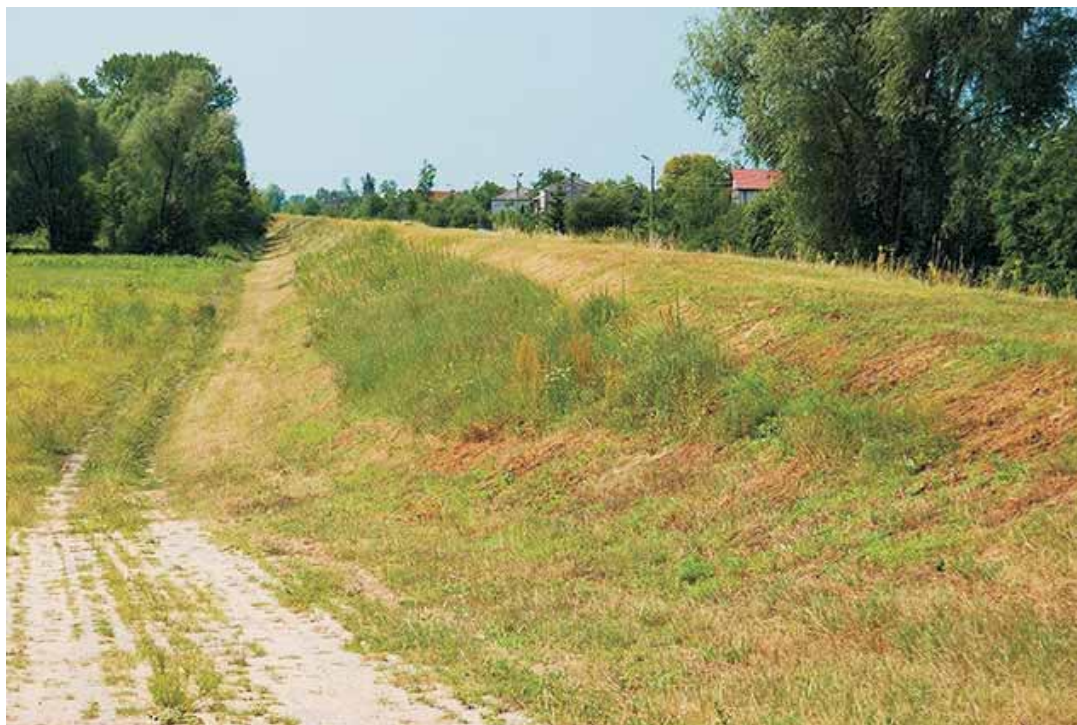
Fot. 69. Wał przeciwpowodziowy w dolinie Wisły
