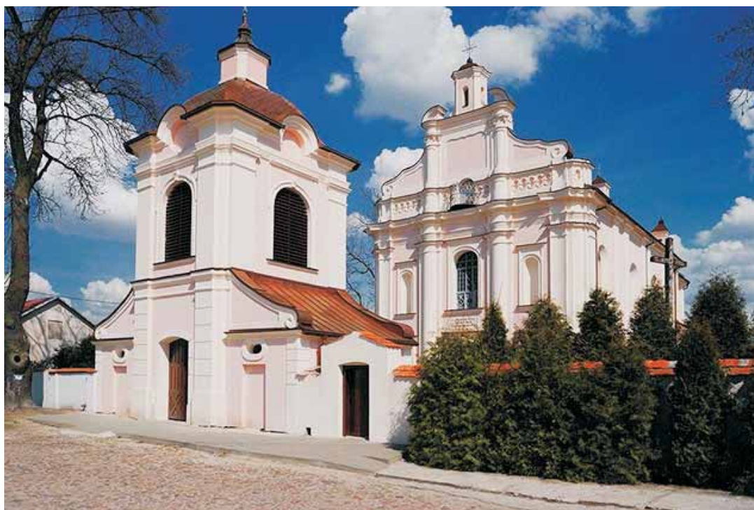
Fot. 1. Zespół kościoła parafialnego w Baranowie - kościół i dzwonnica bramna
