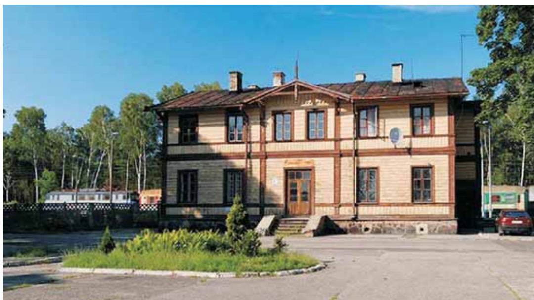
Fot. 20. Stacja kolejowa w Gołębiu
