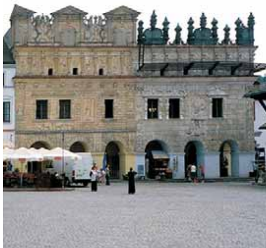
Fot. 47. Kamienice Przybyłów przy rynku w Kazimierzu Dolnym
