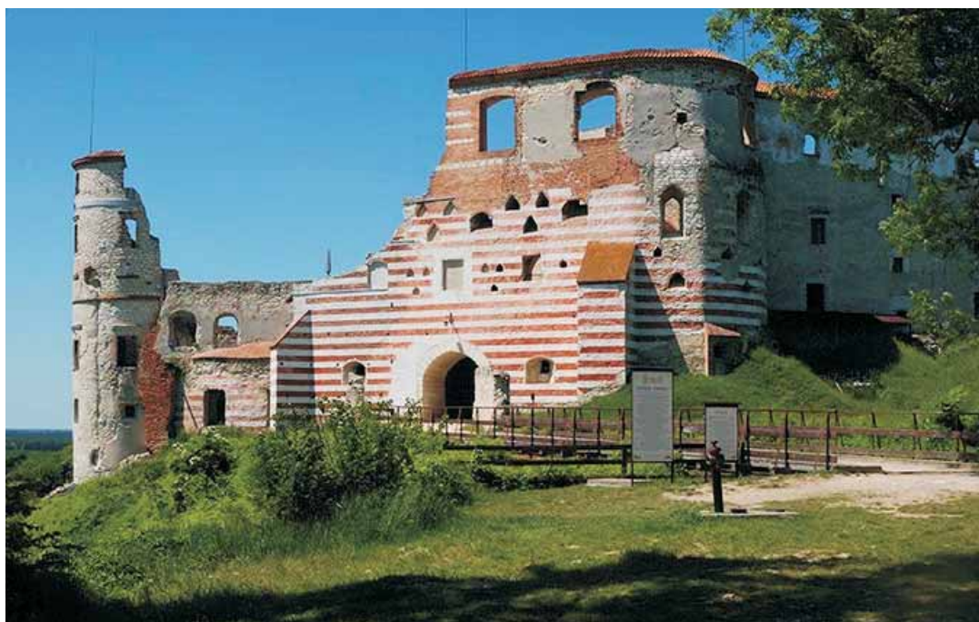
Fot. 28. Zamek w Janowcu od strony bramy wejściowej
