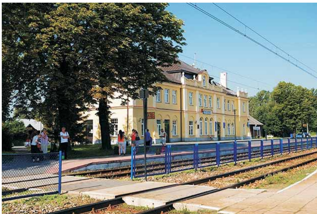
Fot. 16. Stacja kolejowa Nałęczów w Drzewcach
