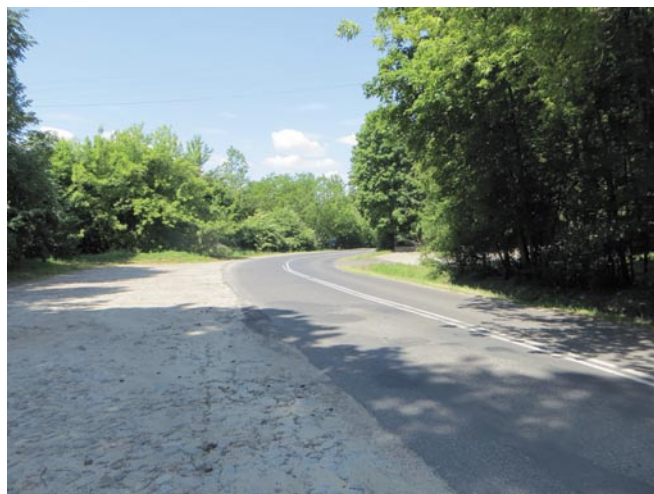
Przebudowa dróg powiatowych nr 2529L i nr 2547L w miejscowościach Cholewianka, Jeziorszczyzna i Kol. Rzeczyca
