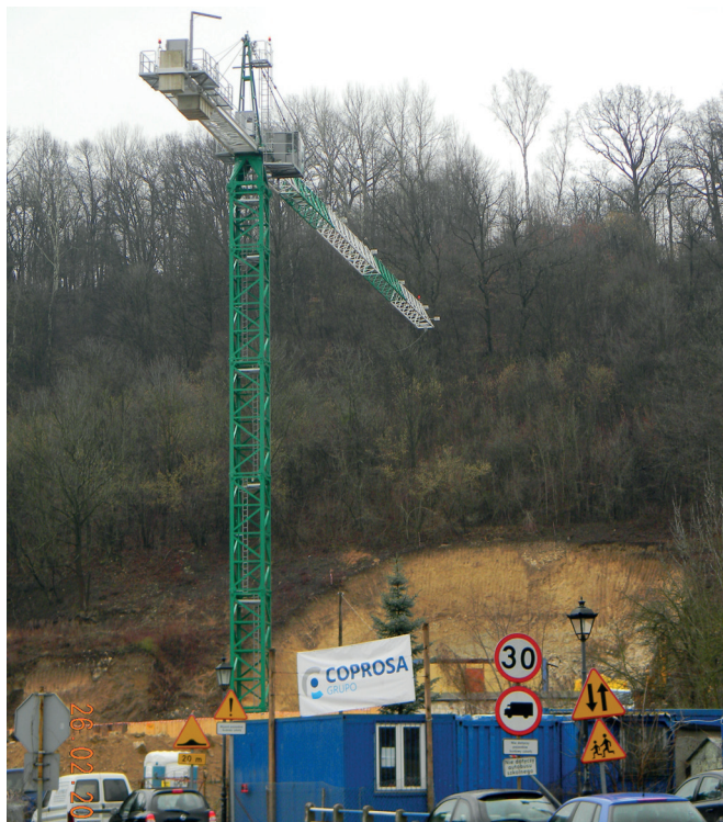
Pod Górą Trzech Krzyży pojawił się dźwig – żuraw oraz ogromny wykop pod fundamenty i piwnice nowej szkoły.
