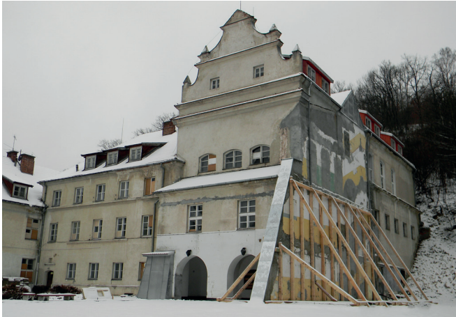
Skrzydło wschodnie zostało rozebrane siłami Gminy Kazimierz Dolny, wykonano również zabezpieczenie przypory ściany korpusu głównego.
