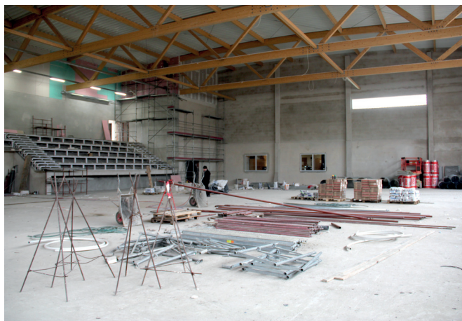
Wnętrze budowanej hali sportowej
