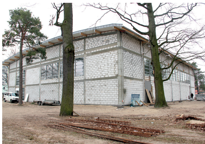
Budowa hali sportowej
